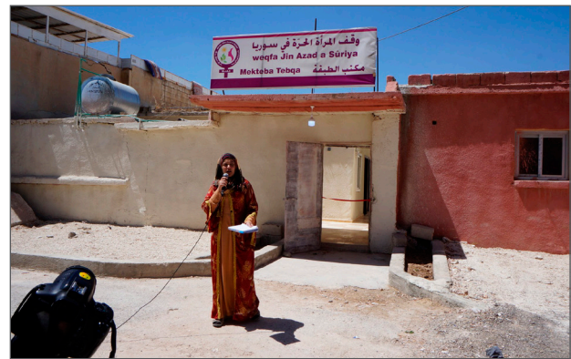
Stiftungsgebäude in Tabqa
